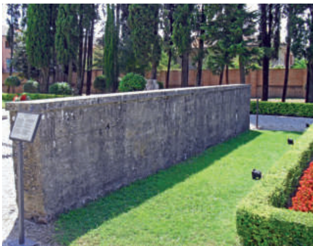
Muro della fucilazione dei Quaranta Martiri
